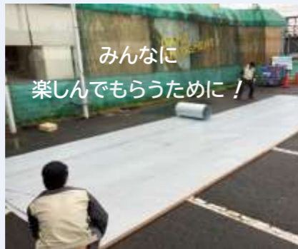
傾斜及び表面補正のため コンパネ+鉄板を敷き詰めました！
